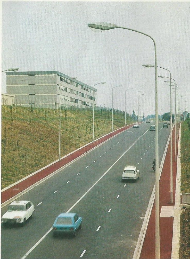
LCM 101 N : crosse à 5 ° 55 W sodium basse pression
