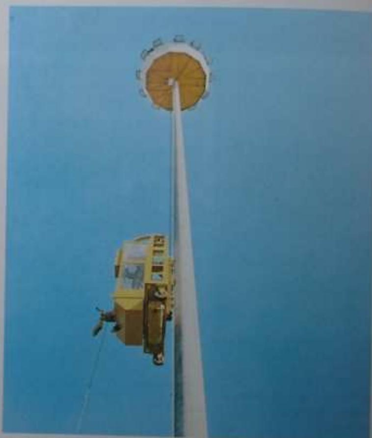
cette solution convient lorsqu'une installation nécessite un grand nombre de mâts et que ceux-ci sont installés sur une aire plane facilitant l'accès au pied du mât (quais de port par exemple)
