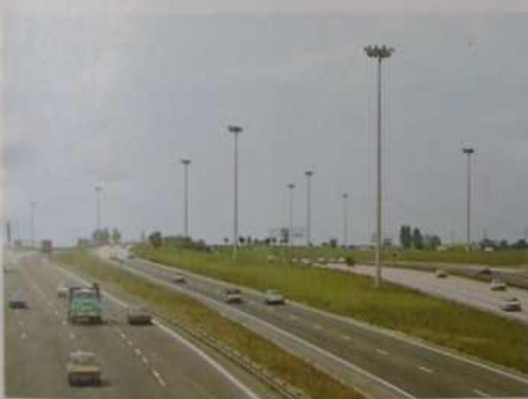
son utilisation convient particulièrement lorsqu'il n'est pas nécessaire de concentrer une grande puissance de feu dans une direction (parking, aire de service, péage, etc...) car elle permet de répartir le flux de manière uniforme sur 360 degrés (couronne complète) ou 180 degrés (demi-couronne)
